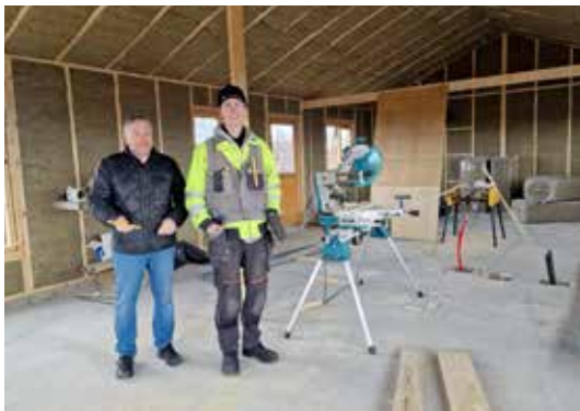
Frá byggingu nýs orlofshúss í Svignaskarði
